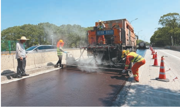
近日，太仓市公路中心采用乳化沥青薄层罩面工艺进行施工，对路面进行“微创修复”。仅用2天就快速解决S359泰洪桥、沙洪桥段等路面出现的抗滑性能下降等病害问题，有效提升了路面雨天行驶的抗滑性能。 杨睿 摄
