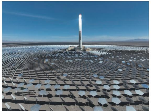
近日，甘肃阿克塞县新能源光热+光伏试点项目实现全容量并网发电。该项目位于甘肃省酒泉市阿克塞哈萨克族自治县四十里戈壁千万千瓦级太阳能发电基地内，总体装机容量750兆瓦，其中光热发电110兆瓦，光伏发电640兆瓦，是我国首批光热+示范电站，也是国内在建单机规模最大的塔式光热发电项目，并网发电后可实现年均上网电量17亿千瓦时。
