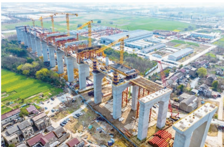
连日来,安徽池州长江公铁大桥建设有序推进。该大桥连接安徽省池州市贵池区和铜陵市枞阳县,按照“公路+城际铁路+城市轨道交通”合并过江的标准建设。
