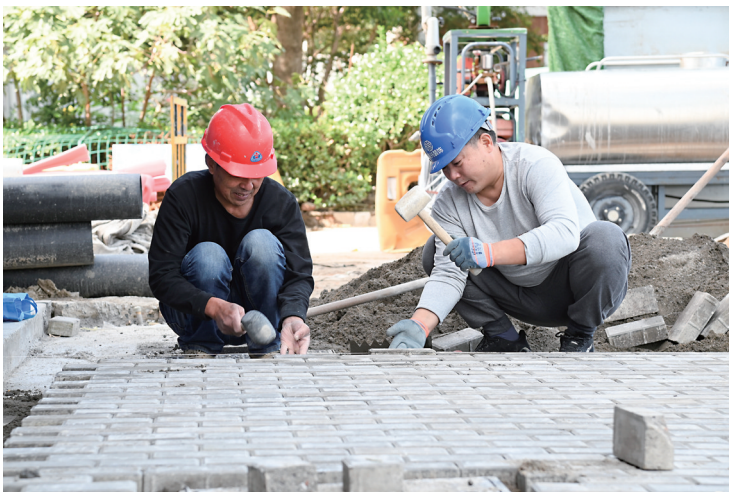
城区北片区老旧小区整治项目主要涉及河西、公园、振兴3个社区13栋楼245户,目前已经完成整个项目进度的70%。图为雨污水分流改造后重铺路面。 吴楚鹤 石玉 丁薇 摄
