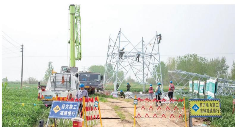
日前,在铭然华港(3兆瓦渔光互补发电项目)施工现场,区供电公司20多名施工人员奋力推进立塔、架线等工作。该工程线路起于铭然华港光伏电站,止于220千伏送变电站,将建成清洁能
