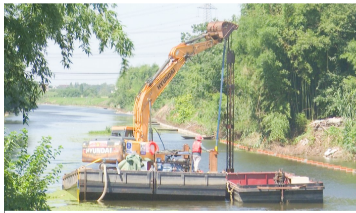
日前,泰州市生产河治理工程张甸段开工,主要实施河道疏浚、岸坡防护,并改造沿线下河踏步、排水口,做好河道绿化防护,切实提升村庄人居环境质量,加快建设宜居宜业和美乡村。
