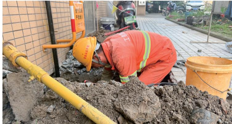
本报讯(记者 黄文婧 丁微)“以前的燃气管使用时间长了,已经锈蚀了。更换后的燃气管是一次性的,防腐质量更好。”施工工人黄宝林介绍道。
