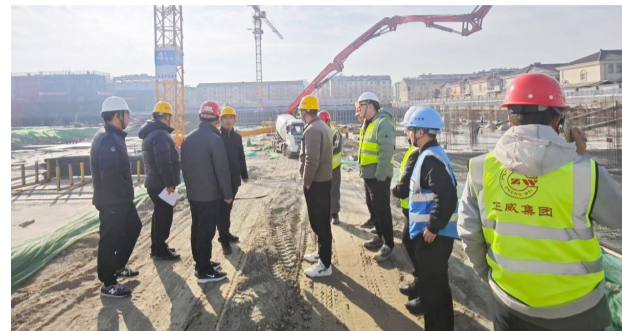
日前,区住建局开展在建工程质量安全专项大排查活动,确保项目无隐患停工、停工期间工地现场安全平稳。曹正 钱雪 摄
