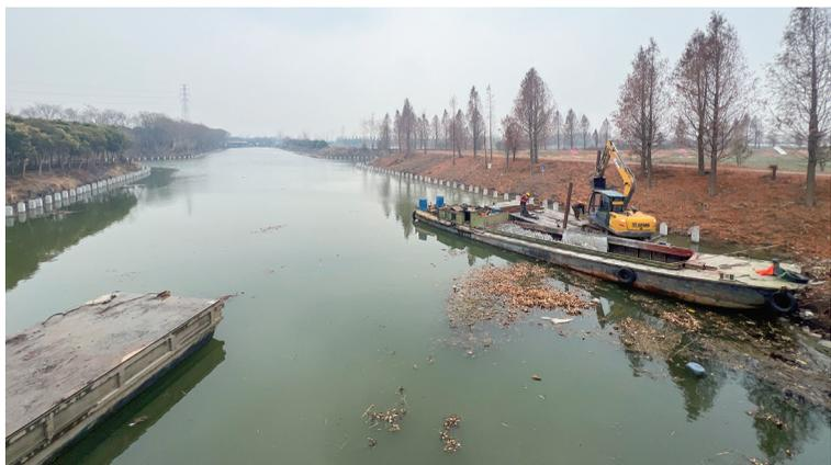
本报讯(记者 黄文婧 丁微 通讯员 徐纪元)昨日上午,记者在位于溱潼灌区续建配套与现代化改造项目一标段——三水街道小杨社区黄村河看到,工人师傅正操控着打桩机械,将一根根长7.5米的水泥桩平稳牢固地插入河床,机械轰鸣声此起彼伏,奏响复工复产的激昂乐章。
