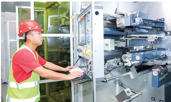
日前,在双登富朗特高性能储能用锂电池项目现场,工作人员抓紧调试新进设备。该项目全部投产后可实现6GWH高性能储能用锂电池产能,预计年新增开票销售41亿元、入库税收4亿元。 颜禹铭 谭海洋 摄
