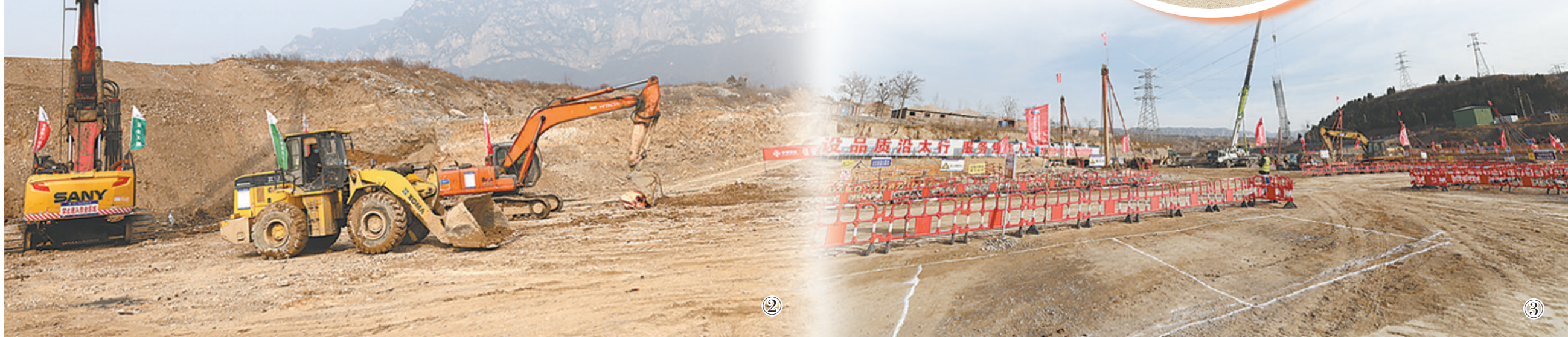
图③ 春日暖阳下的沿太行高速焦济段大河大桥正在有条不紊地施工中。 段玉明 摄
