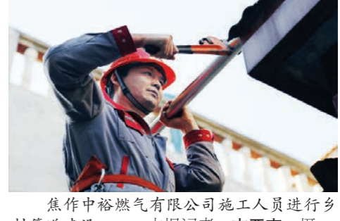
焦作中裕燃气有限公司施工人员进行乡村管道建设。本报记者 吉亚南 摄
