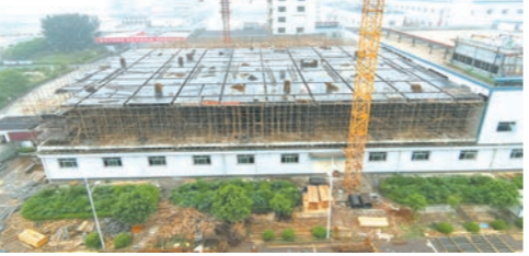
多氟多新材料年产3万吨高纯晶体六氟磷酸锂项目建设现场。许萍 摄
