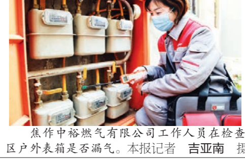
焦作中裕燃气有限公司工作人员在检查小区户外表箱是否漏气。本报记者 吉亚南 摄
