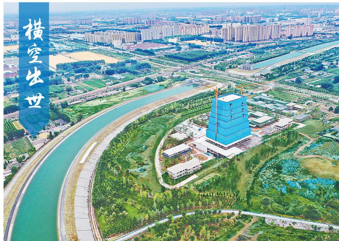
6月12日,具有汉代建筑风格、玉玺造型的南水北调第一楼已封顶。此楼是南水北调焦作城区段绿城带项目的重要节点工程和点睛之笔,高109.32米,地上13层,地下3层,建筑面积约4.8万平方米,现主体工程全部完工,正在进行轻质隔墙安装、外墙粉刷等作业,预计今年年底竣工,对传承文化记忆、彰显城市文脉具有重要意义。
