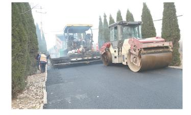
12月13日,在解放区上白作街道春林村乡村道路上,施工 人员正在进行"白改黑"施工。今年以来,该区采取增加道路排 水设施、重新铺筑沥青路面等措施,对6个村破损的道路进行修 整,使村庄面貌焕然一新。 李良贵 摄
