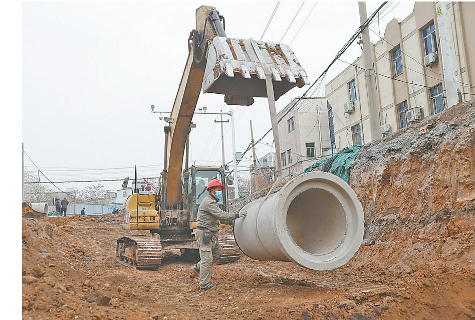
连日来, 放区涉及20余个民生工程的建设项目加快施工, 施工队伍抢抓工期、抓进度, 全力按照时间节点完成任务。图为12月11日, 施工人员在敷设林园路改扩地下排水管网。李良贵 摄
