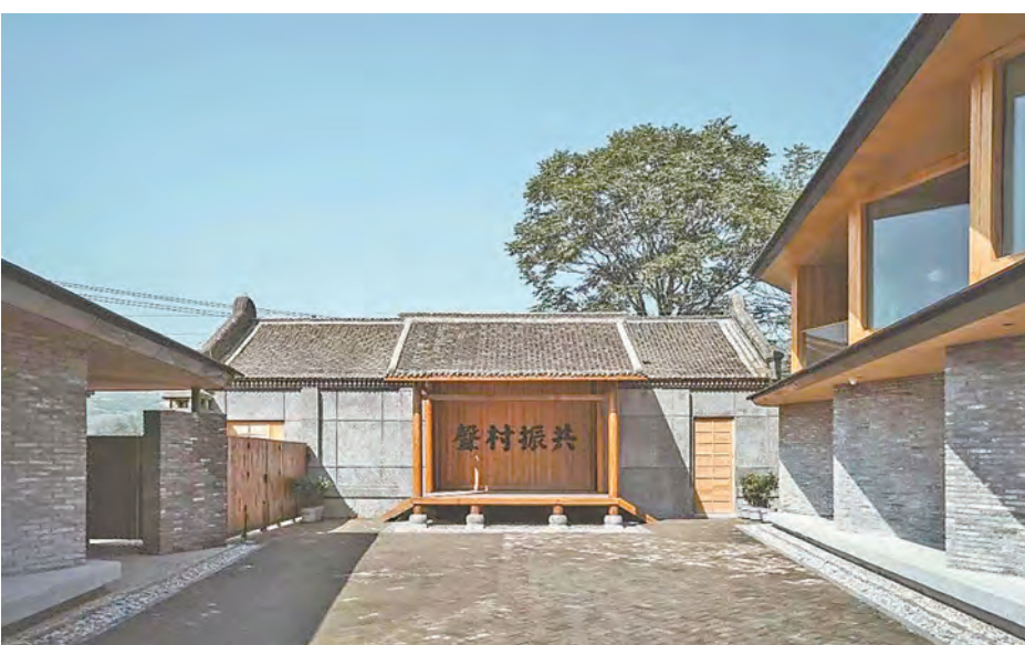
“共报村声”舞台前广场,在保留原有豫北建筑风格的基础上进行改造,使其焕发新生。(场域建筑供图)
