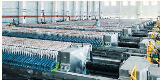
年产20万吨电池级磷酸铁项目生产线。
