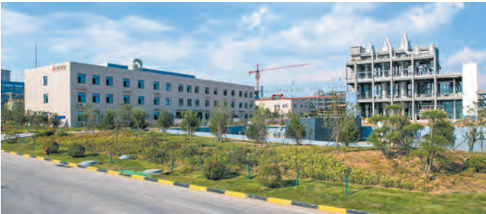
龙佰集团磷酸铁项目。
