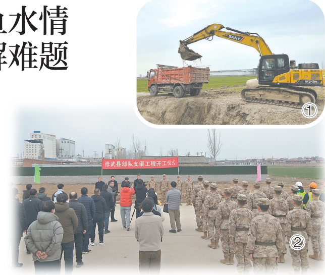
图① 驻焦某部支渠工程施工现场。本报记者 王水涛 摄 图② 驻焦某部支渠工程开工仪式现场。本报记者 王水涛 摄
