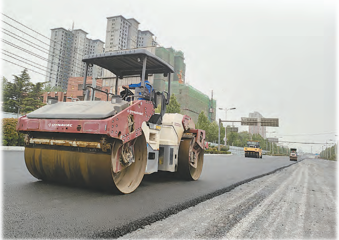
南水北调干渠桥头至普济路口机动车道在进行沥青面层摊铺。
