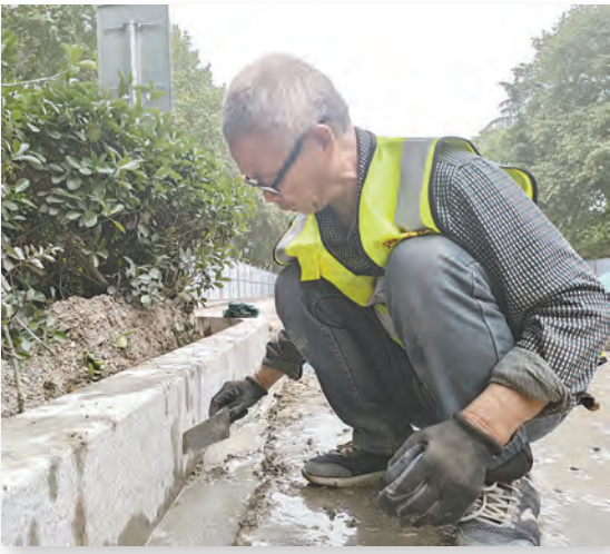
工人正在进行路沿石施工。
