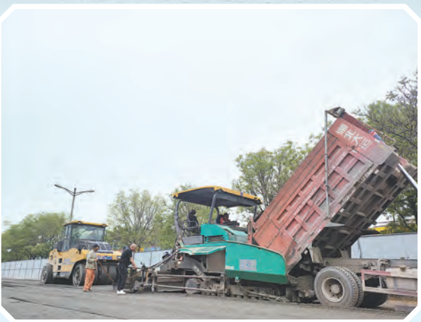
工人在摊铺水泥稳定层。
