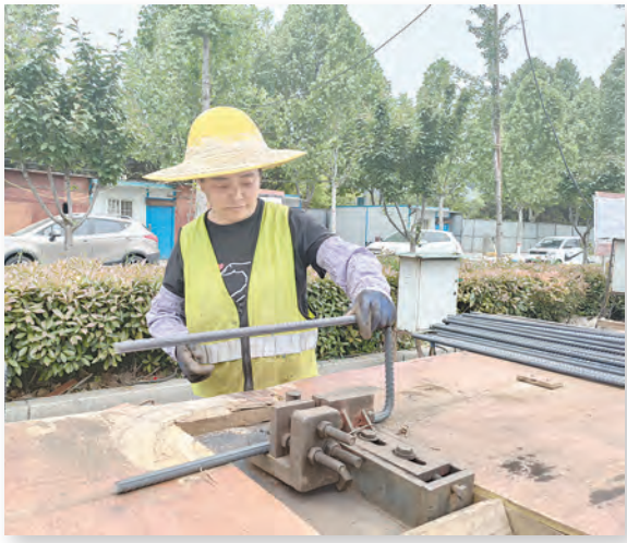
工人在制作桥梁支撑筋。
