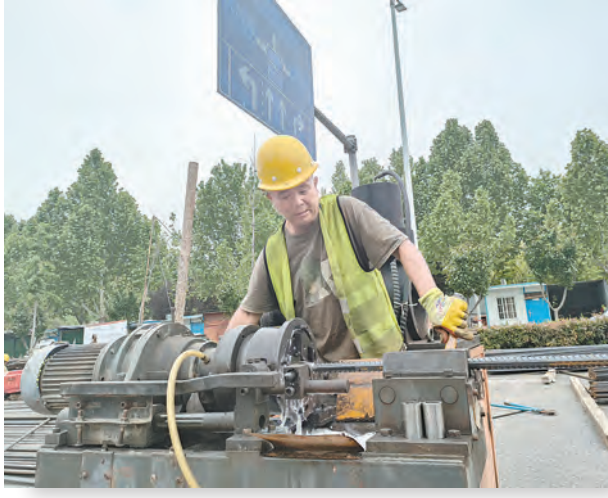
工人正在使用滚丝机床滚丝。
