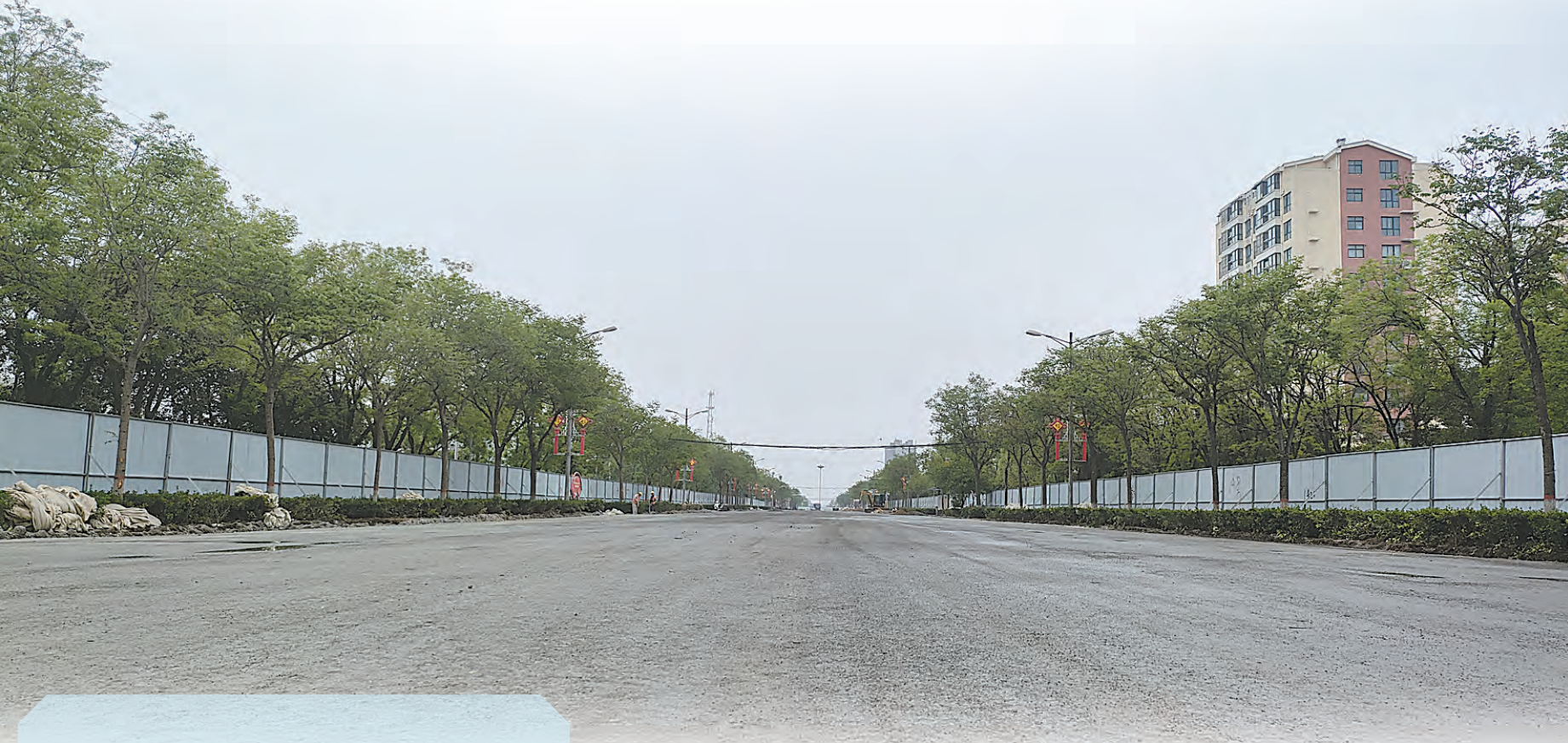
解放东路道路路面基层完工。
