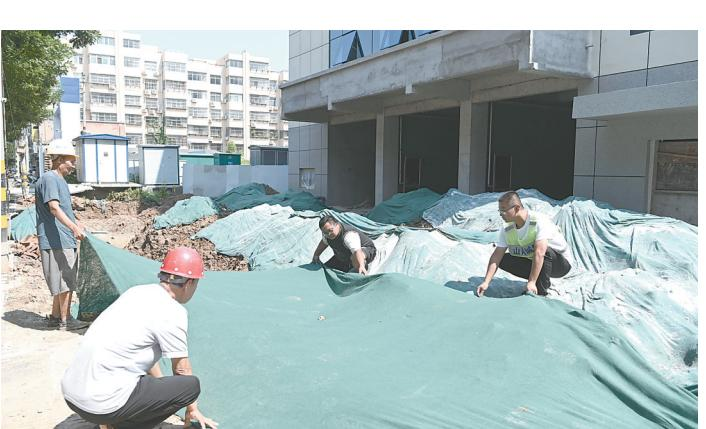
8月29日,山阳区新丰一街一处建筑工地,施工单位对黄土裸露未覆盖问题进行现场整改,落实扬尘污染防治措施。
