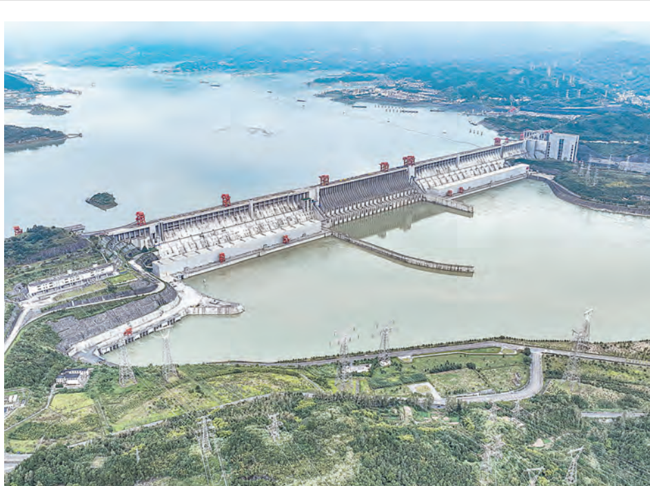
9月27日在湖北省宜昌市秭归县拍摄的三峡大坝及三峡电站(无人机照片)。受近期长江流域持续性强降雨过程影响,三峡入库流量随之升高。中国三峡集团数据显示,9月26日2时15分,三峡电站总出力达2250万千瓦,实现2023年首次满负荷运行。郑家裕 摄(新华社发)
