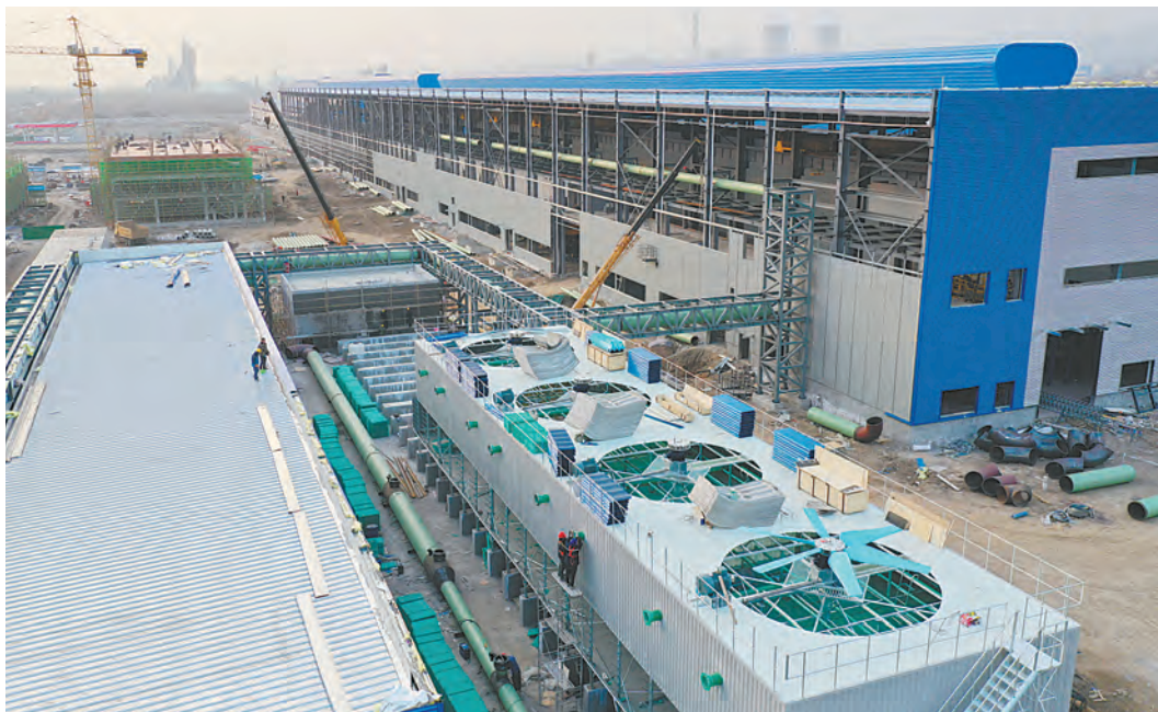
1月15日，河南中源钛业有限公司一期年产1.5万吨钛合金深加工项目生产车间正在进行主设备安装调试。该公司是我市打造千亿级新材料产业集群、中站区打造钛合金新材料研发制造基地的“链主企业”，研发生产的高端钛合金新材料是国家重点支持的战略性新兴产业，项目总投资108亿元，一期生产线正在进行主设备安装调试。
