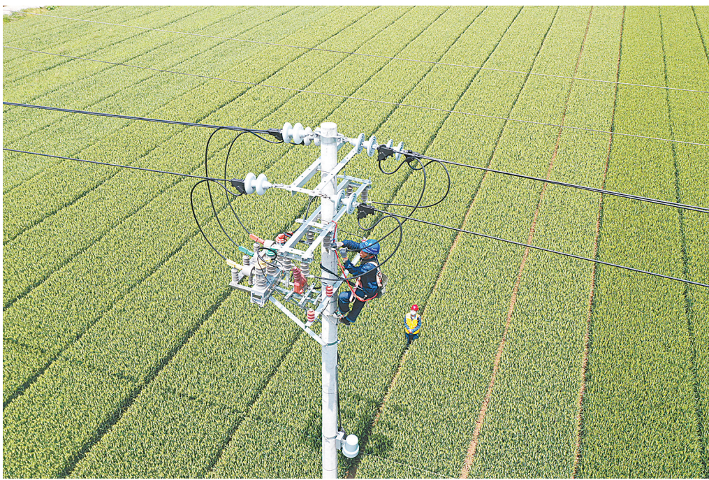
5月15日,沁阳市供电公司农电人员在该市柏香镇西宜作村检修农业用电线路,为“三夏”用电安全夯实基础。杨帆 摄
