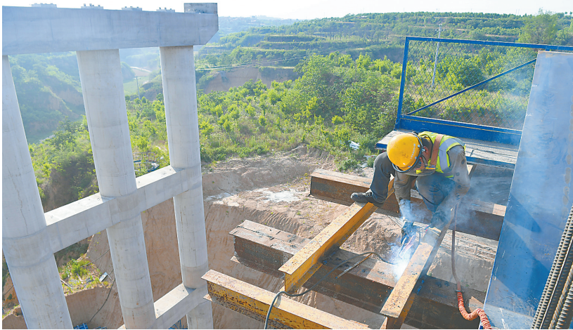
5月23日,中交二航局承建的沁伊高速公路第二标段施工现场,施工人员在43.5米高的桥墩上作业。据了解,该标段桥梁桩基已完成工程量的97.54%,目前进入预制梁架设、钢混组合梁顶推阶段。 本报记者 董蕾 摄
