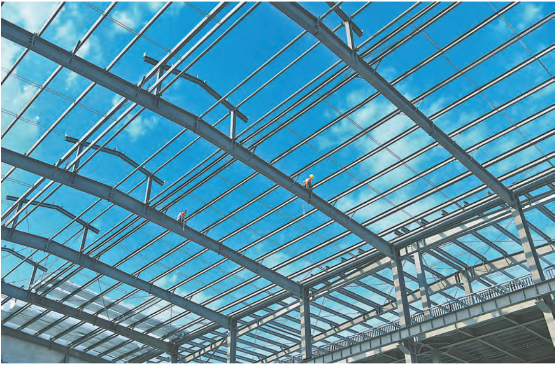
6月29日，解放区虎石新材料高科技产业园项目建设现场，施工队员在搭建厂房钢架。该项目总投资10亿元，计划建2.5万平方米定制化主厂房的微晶材料制品生产线，设计产能为年产300万只的微晶材料。经过紧张施工建设，预计本月底生产厂房可以交付使用。该项目全部建成投产后，预计年销售收入超10亿元，年利税超1亿元。
