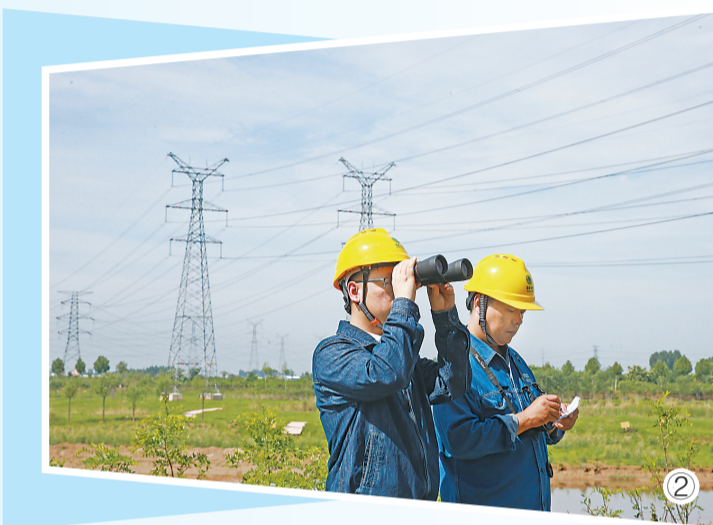
图① 无人机远程督查110千伏黄河输变电工程。 图② 工作人员巡视线路。 图③ 110千伏沙河变电站工程临建复耕复绿。
