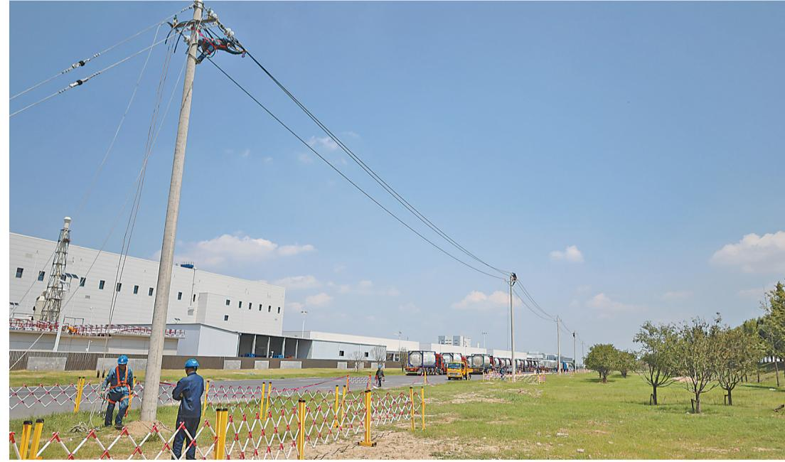
8月13日,温县供电公司施工人员在温县经济技术开发区进行10千伏电力设施架设作业。
