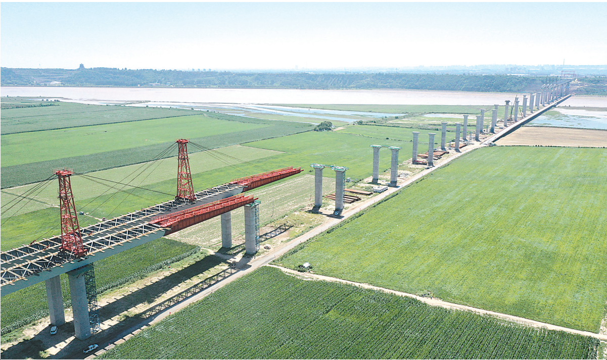
8月21日，温县境内的焦平高速焦梁段黄河特大桥正加紧施工。该项目是河南省高速公路重点项目之一，建成后将连接嵩山、云台山、陈家沟等景区旅游资源，对带动沿线发展具有重要意义。徐宏星 摄
