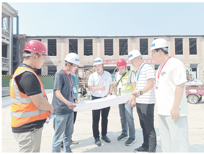
王东（右四）与党员干部深入施工现场，指导项目建设。本报记者 杨珂 摄
