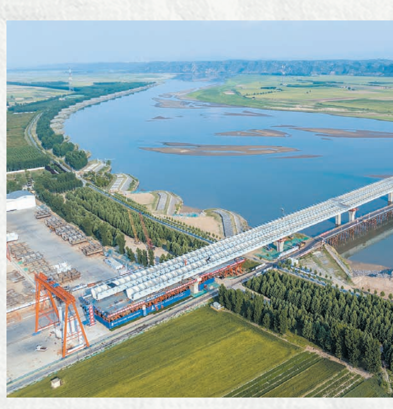
沁伊高速公路孟州黄河大桥施工现场。 本报记者 董 蕾 摄
