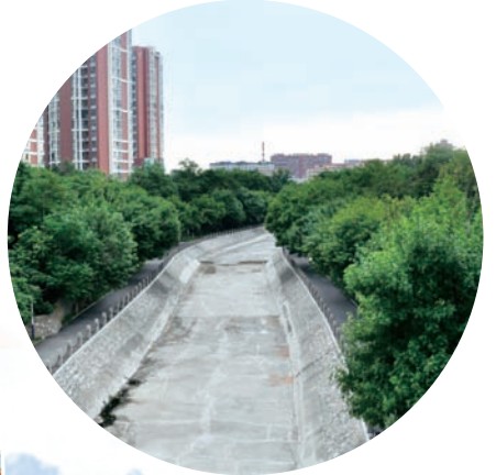
↑和平东街(山阳路—瓮河河)雨水管网工程。
