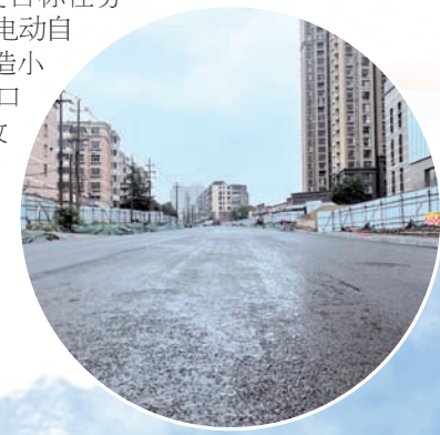
↑陶瓷东院等6个老旧小区改造配套基础设施建设项目。
