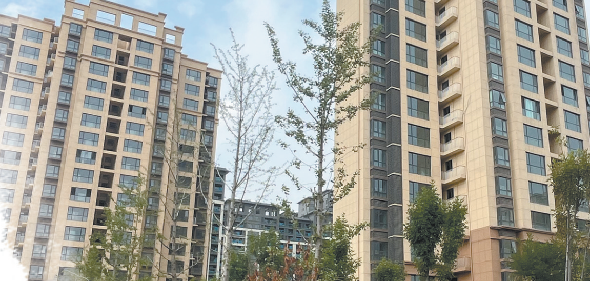
温县前上作棚户区改造项目。
