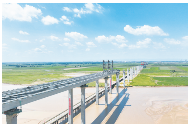
正在飞架南北的焦平高速黄河大桥。
