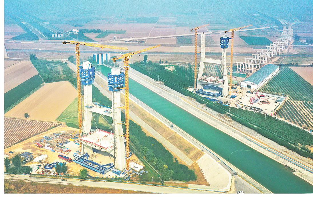
10月29日,河南省公路工程局承建的焦平高速焦作至荥阳段项目南水北调斜拉桥83号墩左塔顺利封顶。至此,该桥梁82号、83号墩两座主塔封顶任务比原计划提前45天完成,大桥建设即将全面进入现浇混凝土梁施工新阶段。
