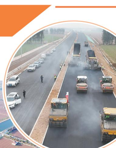
10月29日，由中交一公局承建的沿太行高速焦作至济源段项目正在进行沥青上面层摊铺施工。段玉明 摄
