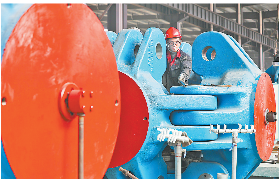
11月18日,焦作天宝恒祥机械科技有限公司智慧谷项目的工作人员在安装六面顶压机。该项目建成运行有助于天宝恒祥打造以六面顶压机设备为基础,整合上下游资源、带动产业链协同发展的全产业链。
