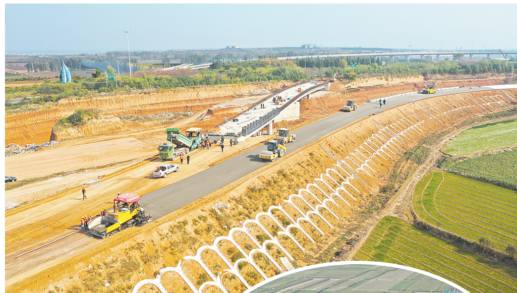
↑11月6日,由中交三公局承建的沿黄高速武陟至济源段项目四标济源南互通水稳基层施工现场。本报记者 刘金元 摄
