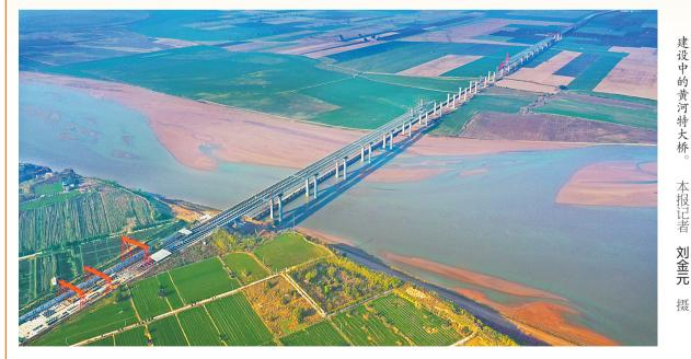
本报讯(记者朱晓琳 通讯员段 桥包含主桥和南水北调内引桥,其中 克服种种技术难题,经过两年多的艰 **玉明)** "起吊!" 11月20日,河南省公 路工程局承建的焦平高速焦作至荥阳 段项目四标黄河特大桥主桥施工现 场,一块块长16米重200吨的钢箱 梁,缓慢被吊到20米高的桥墩上。
