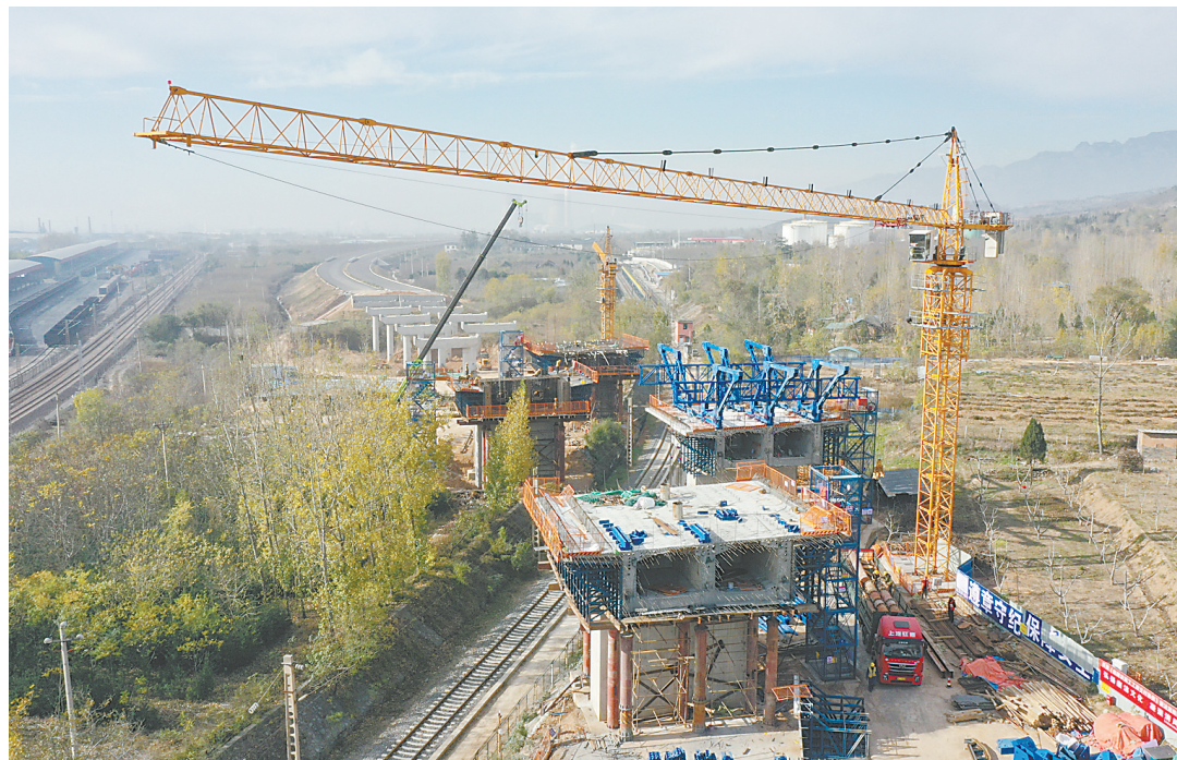
11月30日,沁阳市西万镇,沿太行高速公路焦作至济源段跨沁阳7004油库铁路分离式立交桥工地,工人们在加紧施工,保障项目进度。沿太行高速公路焦作至济源段项目是省高速公路“13444工程”第一批开工的切块项目之一,建成后 will 开辟对接京津冀一体化发展和沿太行山区域的一条快捷旅游大通道,对进一步加强焦作乃至河南与京津冀地区的融合发展有着重要意义。杨帆摄
