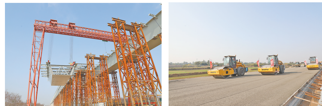
12月1日,由河南省公路工程局承建的焦平高速焦梁项目四标黄河特大桥钢架梁正在加快推进。段玉明 摄
