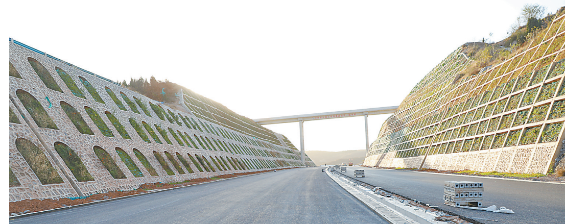
11月30日,由中交三公局承建的沿黄高速武陟至济源段项目四标水稳基层摊铺正在施工。段玉明 摄
