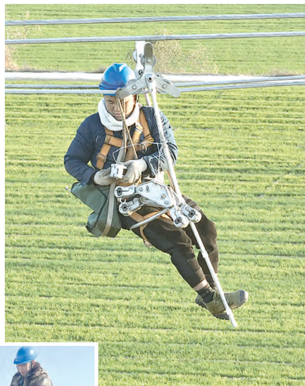
(本栏照片均为覃怀—黄河110千伏线路跨越晋新高速公路工程施工现场)
