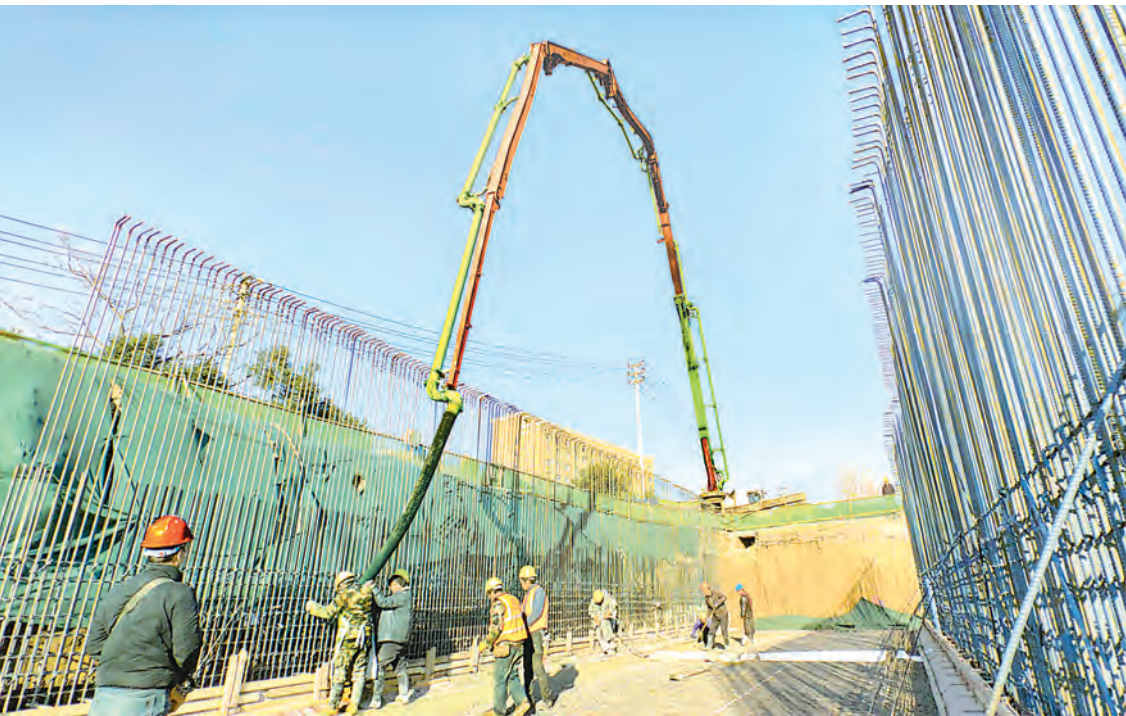
12月6日,打通“断头路”市站前路(普济路-南通路)道路工程施工现场,施工队在浇筑普济河箱涵底板混凝土。该项目由市投资集团有限公司承建,项目规划为东西向城市主干道,道路全长约420米,双向六车道。目前,该项目雨污水管网、主干道及慢车道的路床已全部完成,开始浇筑普济河箱涵底板混凝土,近日将铺设主干道水稳基层,计划12月中旬道路主体完成。 本报记者 刘金元 摄
