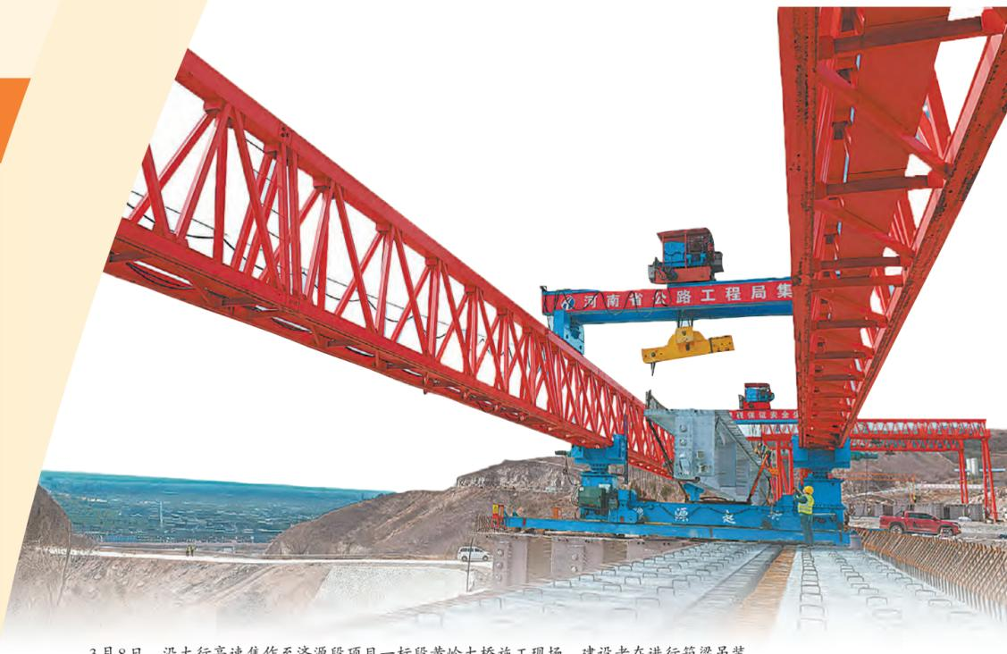
3月8日,沿太行高速焦作至济源段项目一标段黄岭大桥施工现场,建设者正在进行箱梁吊装。
