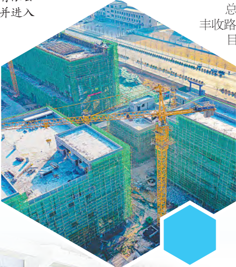
→马村区焦作健康元生物制品有限公司高端原料药项目所有建筑主体结构均已封顶,1标段二次结构施工正在进行中。
