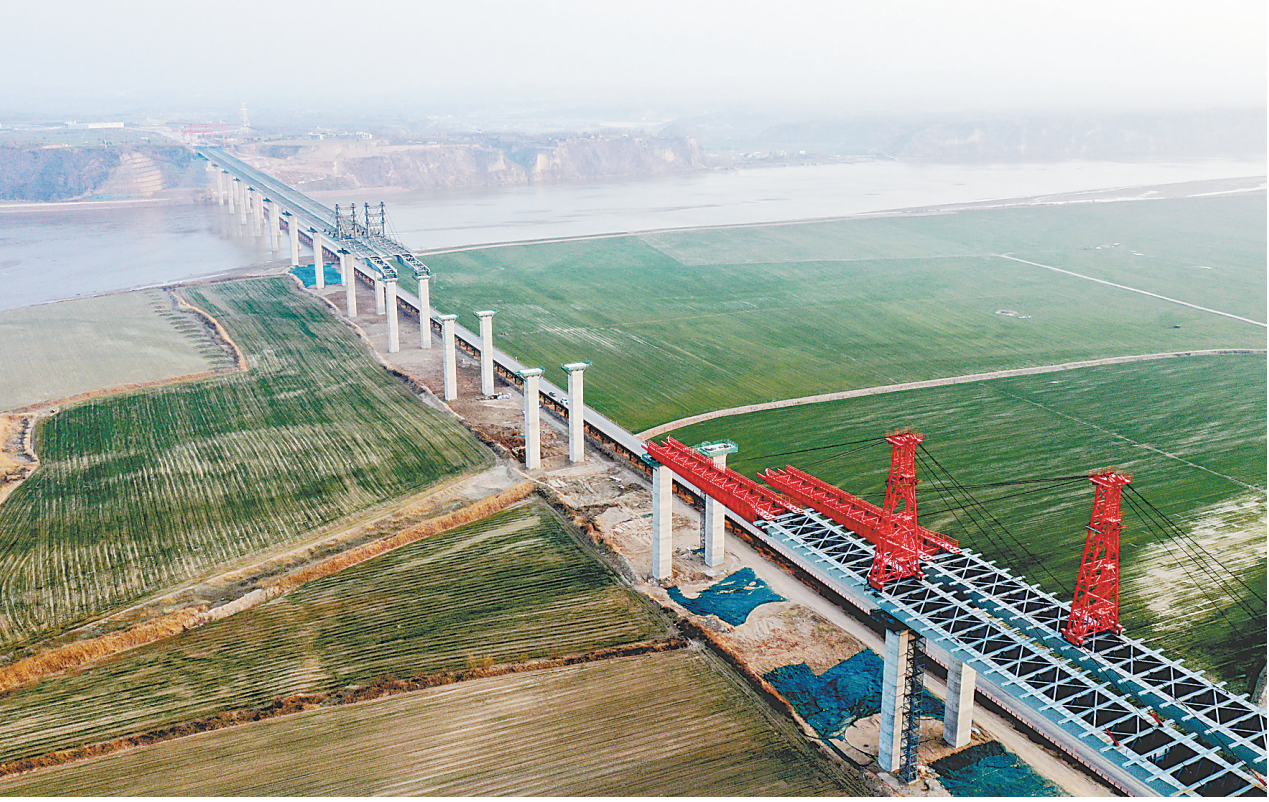
2月26日拍摄的焦平高速公路黄河特大桥主桥施工现场（无人机照片）。河南焦（作）平（顶山）高速公路跨黄河特大桥主桥工程目前正加紧施工。焦平高速公路黄河特大桥主桥全长3656米，建设标准为双向六车道，设计时速120公里，工程计划于2026年建成通车。徐宏星 摄（新华社发）
