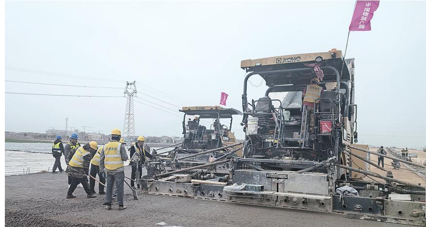
沿黄高速武陟至济源段三标项目水稳基层试验段顺利铺筑完成。
