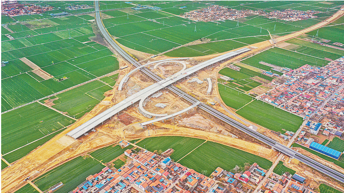
3月31日，沿黄高速北冷枢纽互通施工现场，施工队在进行桥面铺装。沿黄高速武陟至济源段项目是市“三十工程”十大基础设施项目之一。由中建八局承建的北冷枢纽互通合计7座桥梁，由1座主线桥和6座匝道桥组成，该枢纽互通于2022年10月11日开工建设，目前互通下部构造、现浇梁已全部完成。 本报记者 刘金元 摄
