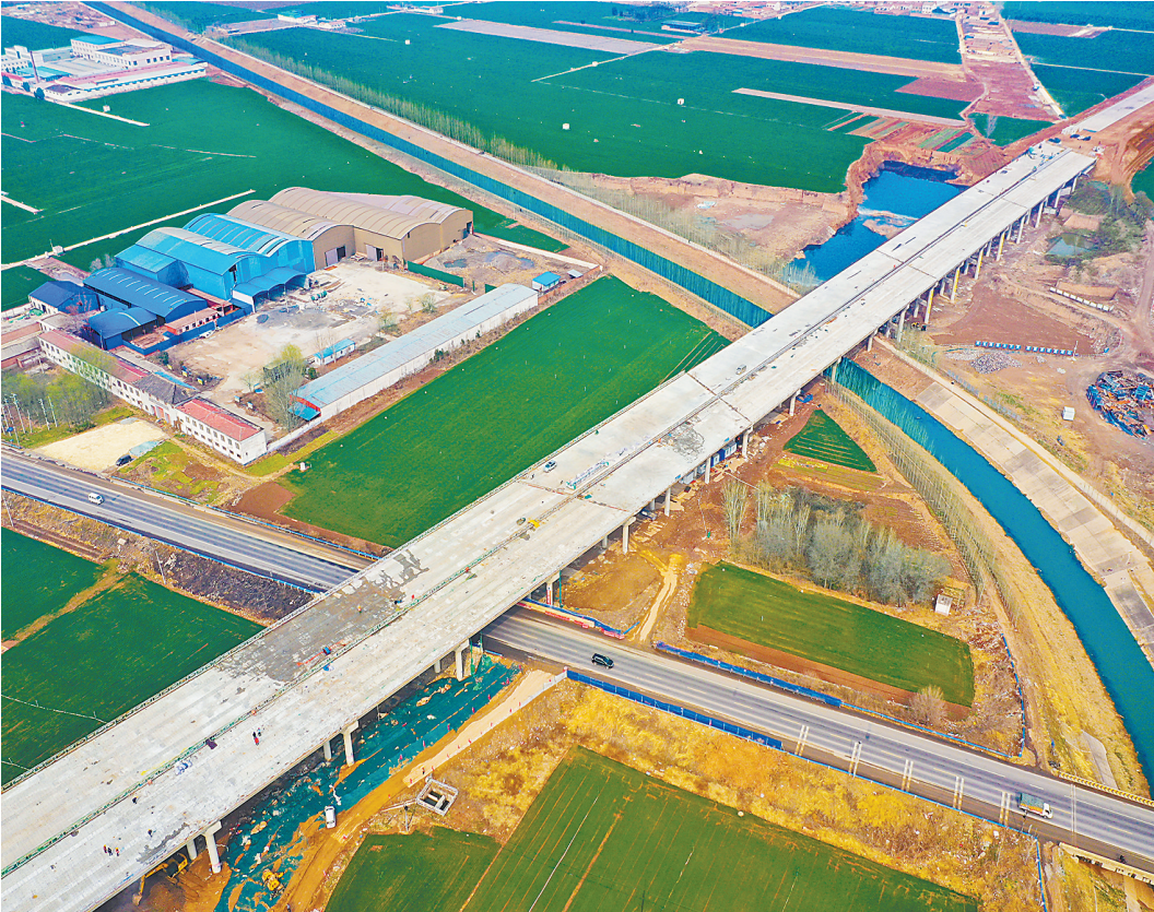
3月29日，焦平高速焦黎段二标段济河大桥施工现场，河南省公路工程局的建设者在进行桥面防撞护栏施工。今年年初以来，焦平高速二标段经理部抢抓施工有利时机，加速推进项目建设，确保第一季度完成产值6432万元。
