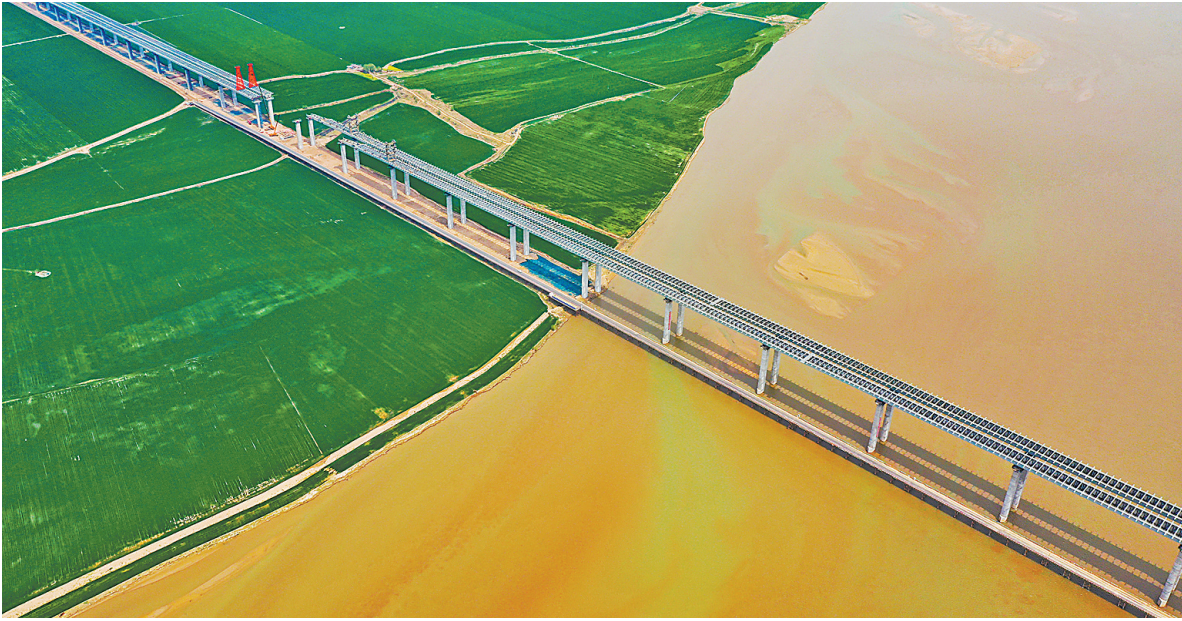
4月12日，焦平高速焦作至荣阳段项目四标黄河特大桥施工现场，工人们在进行钢箱梁顶推。焦平高速公路项目计划2026年建成通车，将成为连接嵩山、云台山、黄河、陈家沟等旅游资源的又一条高速通道，对促进黄河流域高质量发展，带动旅游资源开发整合，促进沿线区域经济发展具有重要意义。本报记者 刘金元 摄
