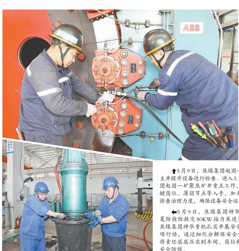
↑5月9日，焦煤集团赵固一矿机电队职工对主井提升设备进行检查。进入5月份以来，焦煤集团赵固一矿聚焦矿井重点工作，从重点设备、关键岗位、薄弱节点等入手，加大设备检查和隐患排查治理力度，确保设备安全运行。王代华 摄
