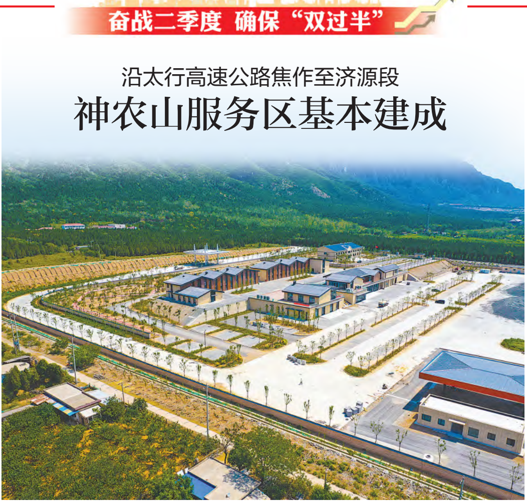
6月16日，在沿太行高速焦作至济源段项目二标神农山服务区建设现场，中交一公局的建设者在进行场内绿化以及内部装修工作的扫尾工作。
